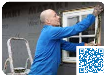
Taping rundt vindu
