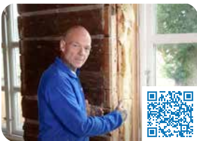
Fuktmekanikk i gamle hus
