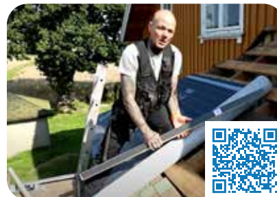
Undertak og sløyfebånd
