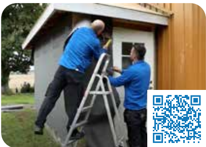
Montering av vindsperre
